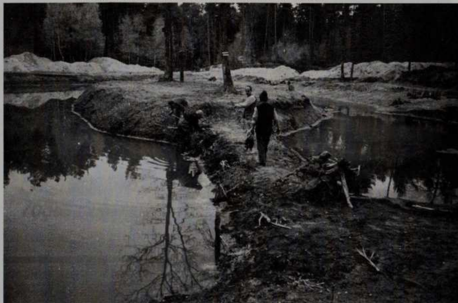
Grundbepflanzung der Flachwasserzone
